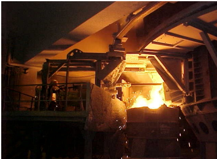
La coulée du four
